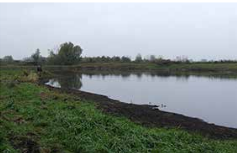
Contrôle administratif d'un dossier loi sur l'eau à Tilloy-les-Marchiennes
